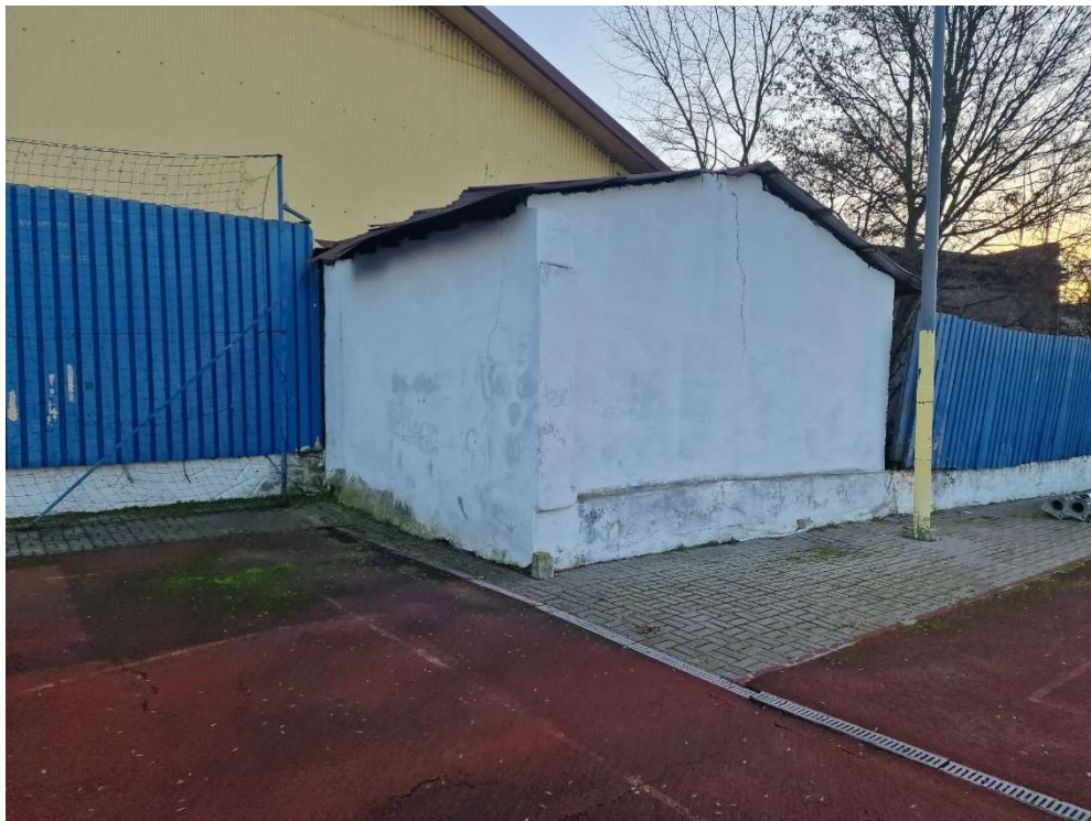
Widok nr 2: elewacja północna i zachodnia
